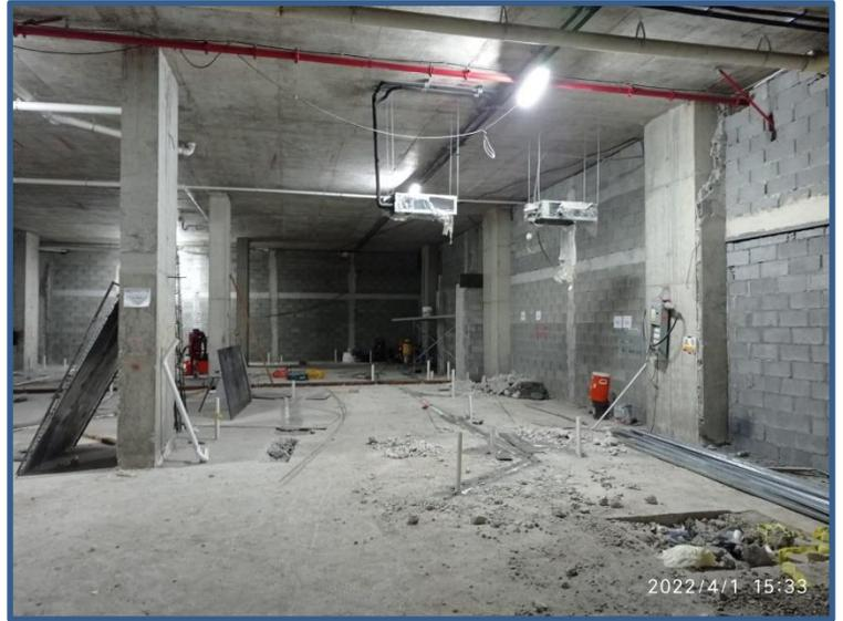
**Instalaciones pluviales y sanitarias de piso y paredes, levantar paredes de bloques y tabiquería liviana, preparativos para colocar piso de concreto nivelador.**
