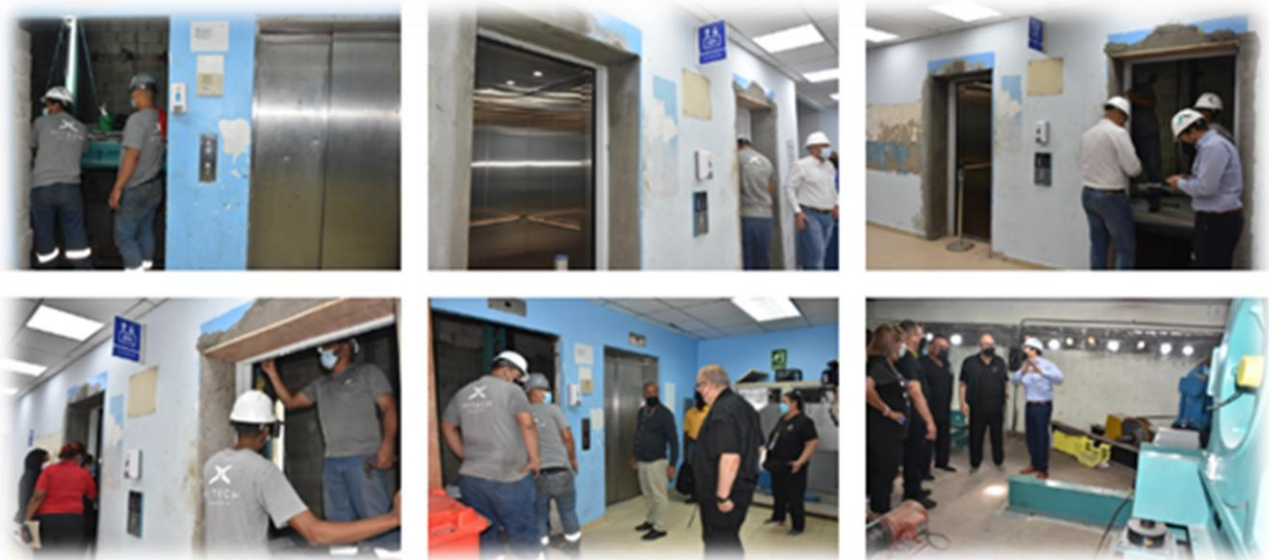
Trabajos para la instalación de seis (6) nuevos, modernos, silenciosos y de alta tecnología, en el Hospital Manuel Amador Guerrero.
