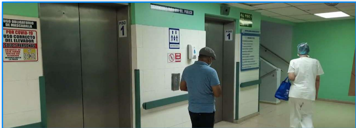
Actualmente se inicia el funcionamiento de 3 elevadores en el Hospital Manuel Amador Guerrero en Colón.
