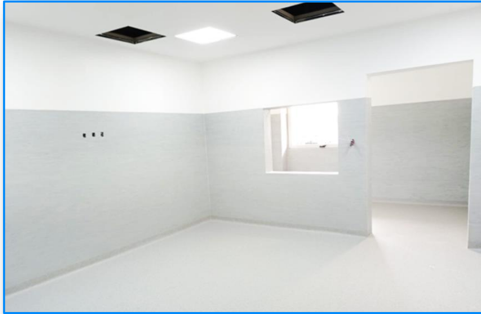
Área de tomógrafo y rayos X, en fase de acabados.
